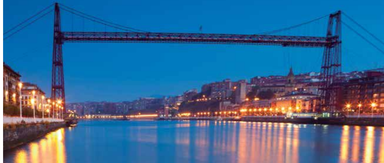
Pont de Biscaye
